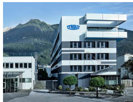
Hoofdkantoor van TYROLIT in Schwaz (Oostenrijk)
