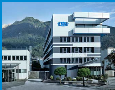
Hoofdkantoor van TYROLIT in Schwaz (Oostenrijk)
