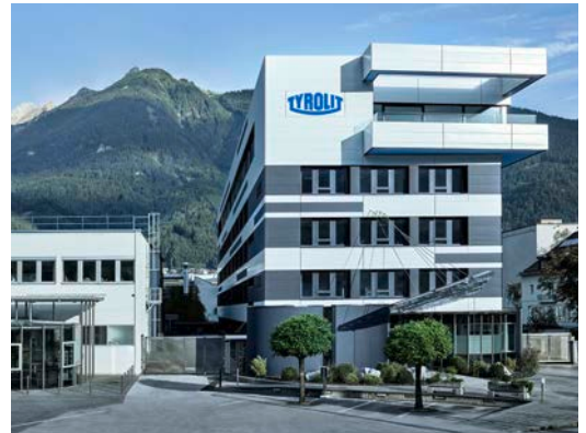
TYROLIT hoofdkantoor in Schwaz, Oostenrijk.
