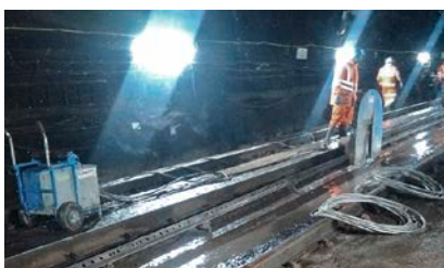
4 VERENIGD KONINKRIJK, Glasgow Renovatie van de Queen Street Tunnel
