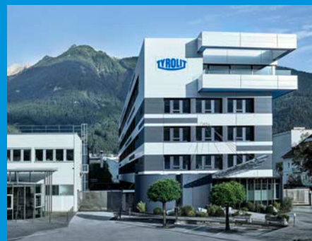
Hoofdkantoor van TYROLIT in Schwaz (Oostenrijk)
