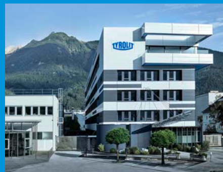
Hoofdkantoor van TYROLIT in Schwaz (Oostenrijk)
